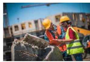
un chantier le chantier
