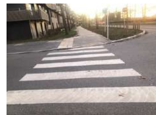
un passage piéton le passage piéton
